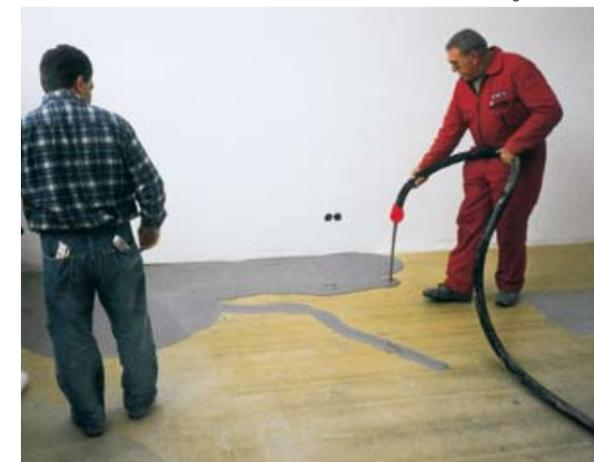
Con las bombas sinfín universales puede trabajarse incluso solados de cemento autonivelantes (aquí p. ej. desde una S 5<sup>EV/TM</sup> a una planta de producción).
