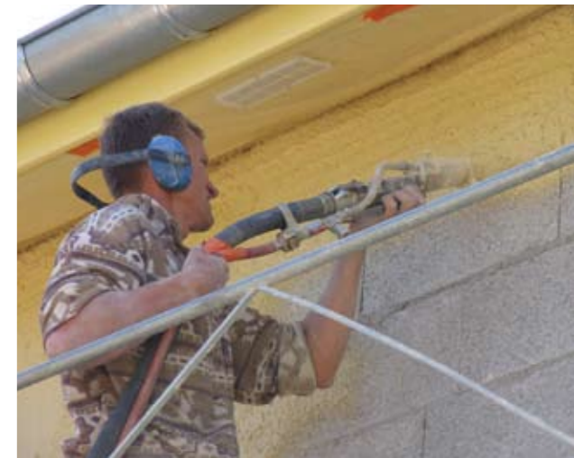
Las bombas sinfín SP 11 pueden emplearse tanto en el exterior como en el interior para todo tipo de mezclas de obra y morteros prefabricados con una granulometría de hasta 6 mm.
