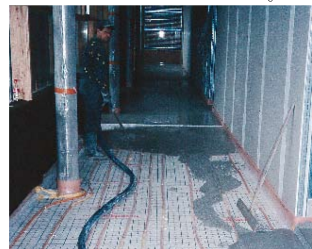
Con los elementos de bombas sinfín apropiados se puede incluso bombear solado autonivelante sin problemas y de forma rentable.
