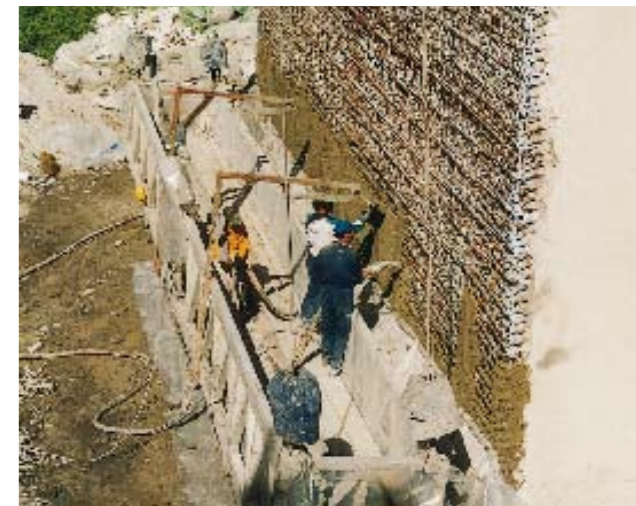
También son idóneas para trabajos de gran envergadura: saneamiento del hormigón en un puente de autopista en Italia.
