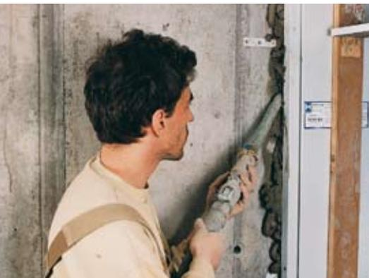
Llenado de marcos no supone ningún problema con Sprayboy. Mediante un telemando permite conectarlo y desconectarlo con toda comodidad.
